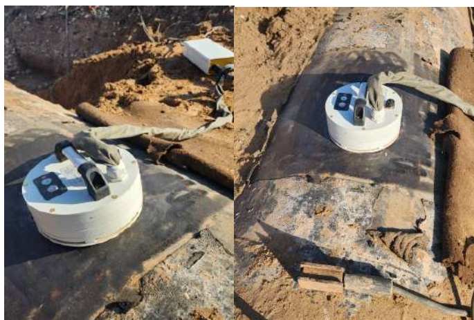
Рисунок 3 - Индуктор для сопутствующего межслойного подогрева сварных соединений при заварке технологических отверстий
