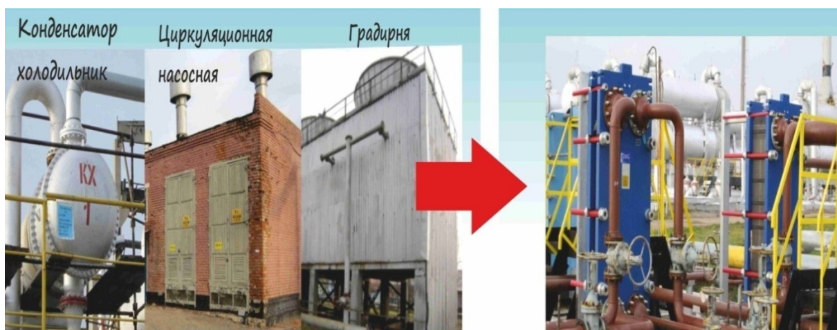
Рисунок 2 — Результаты внедрения пластинчатого теплообменника
