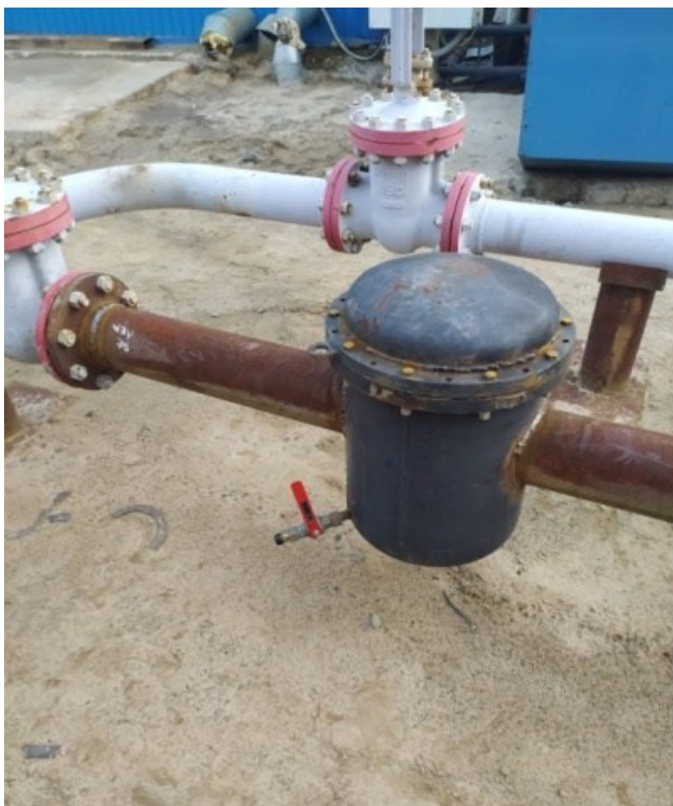
Рисунок 1 – Узел фильтра нефтепродуктов
