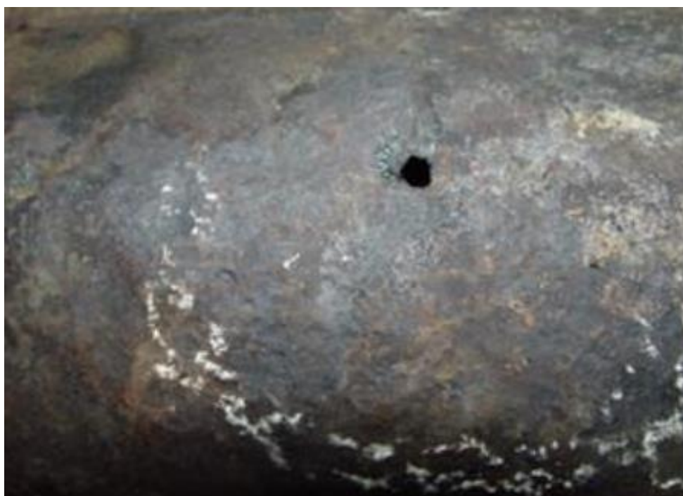
Рисунок 3 – Свищ в печной трубе [5]
