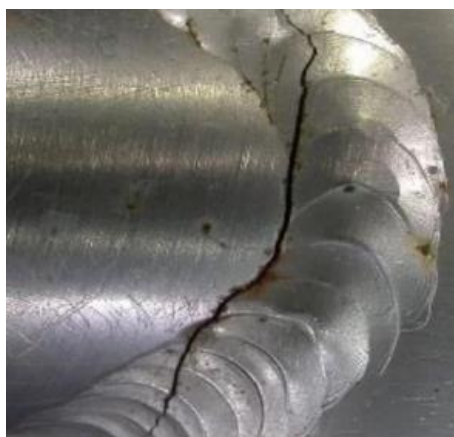
Рисунок 1 – Трещина в сварном соединении [5]
